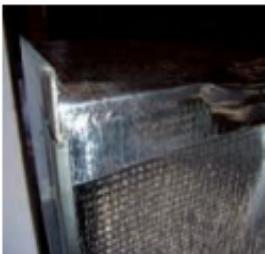
Ventilacioni kanal izolovan TROCELLEN DUCT LVF REF materijalom koji je pričvršćen Duplex samolepljivom trakom
